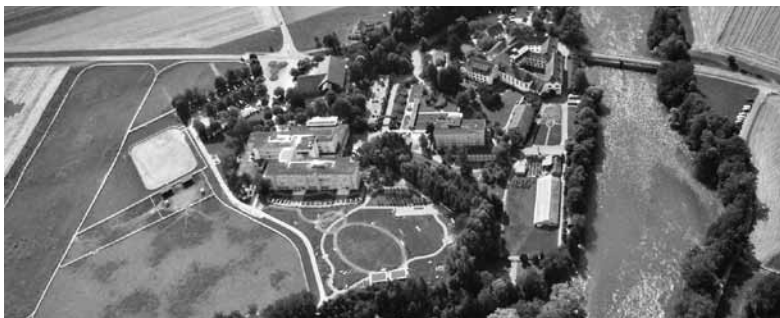
Übersicht über die gesamte Anlage
